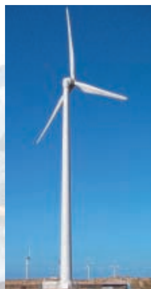
Zephyros met 1,6 MW generator 15-25 omw/min
