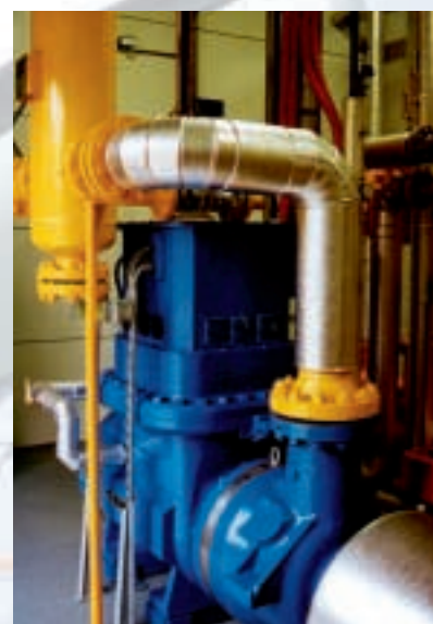
Gasexpansieturbine met pm-generator 30.000 omw/min en magneetlagering
